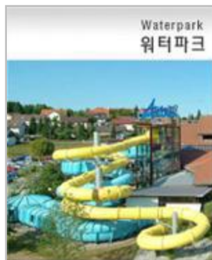
수영장, 워터슬라이드 등 시공
